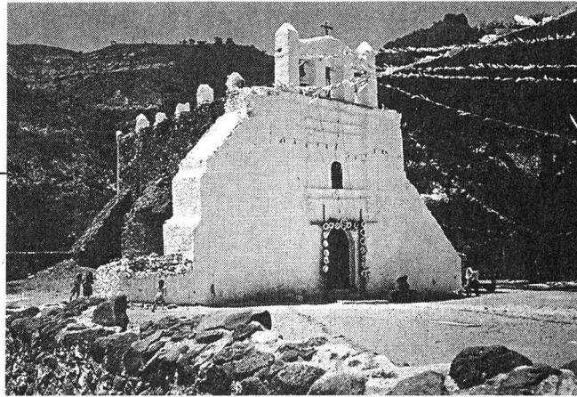
Hualula. Frente del edificio (J. B. Artigas, 1983).
