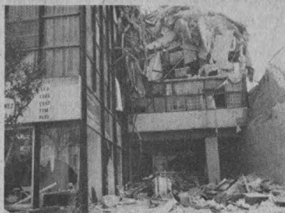
En 90 segundos se derrumbaron 371 edificios, el 16 por ciento de los cuales había sido edificado después del sismo de 1957 en la zona blanda de la ciudad.
