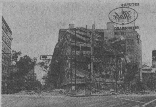
Después de los sismos de 1985 se evaluaron los daños y sus causas, lo que dio lugar al Reglamento de Construcciones del DF.
