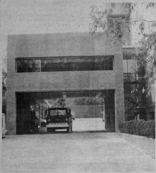
Sus instalaciones se encuentran ubicadas en el costado sur del Estadio Olímpico Universitario.
