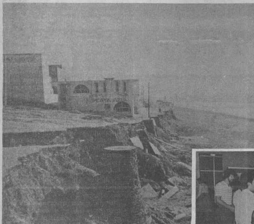
En el fraccionamiento "Playas de Tijuana", por falta de investigación previa a la construcción, se perdieron 20 metros de playa y siete metros de boulevard a causa de movimientos de arena.
