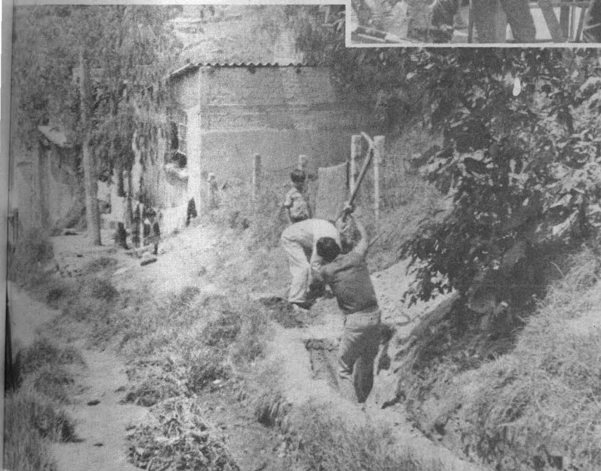
Los colonos participan en la instalación y ejecución de sus propios servicios.
