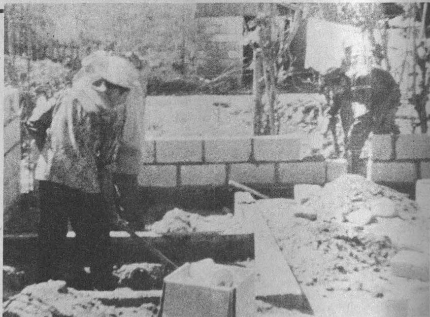
Proceso de edificación de la UMR de la población del Soconusco, Chiapas, en cooperación comunitaria.
