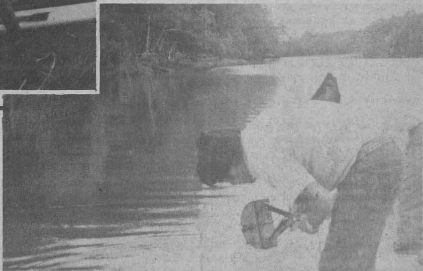
Obtención de sedimentos recientes por medio de Draga Van Veen, en la Laguna Mecoacán.
