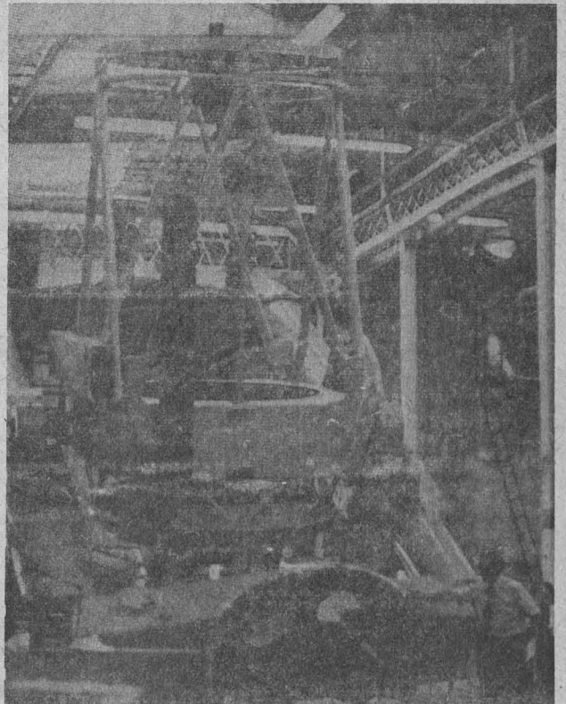
Instalación del telescopio de 2.13 m de diámetro, en San Pedro Mártir, B.C.N.
