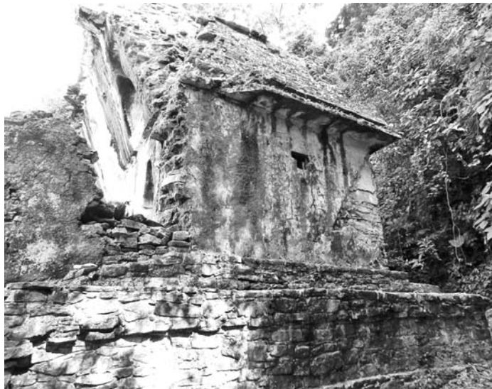
Edificio de Palenque.
