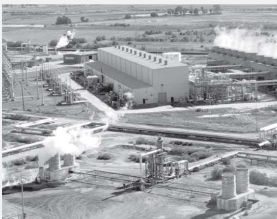
Campos geotérmicos de Cerro Prieto, en Mexicali.
