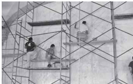
Los trabajos de restauración.
