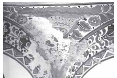
Detalles del deterioro en cúpula y pechina.
