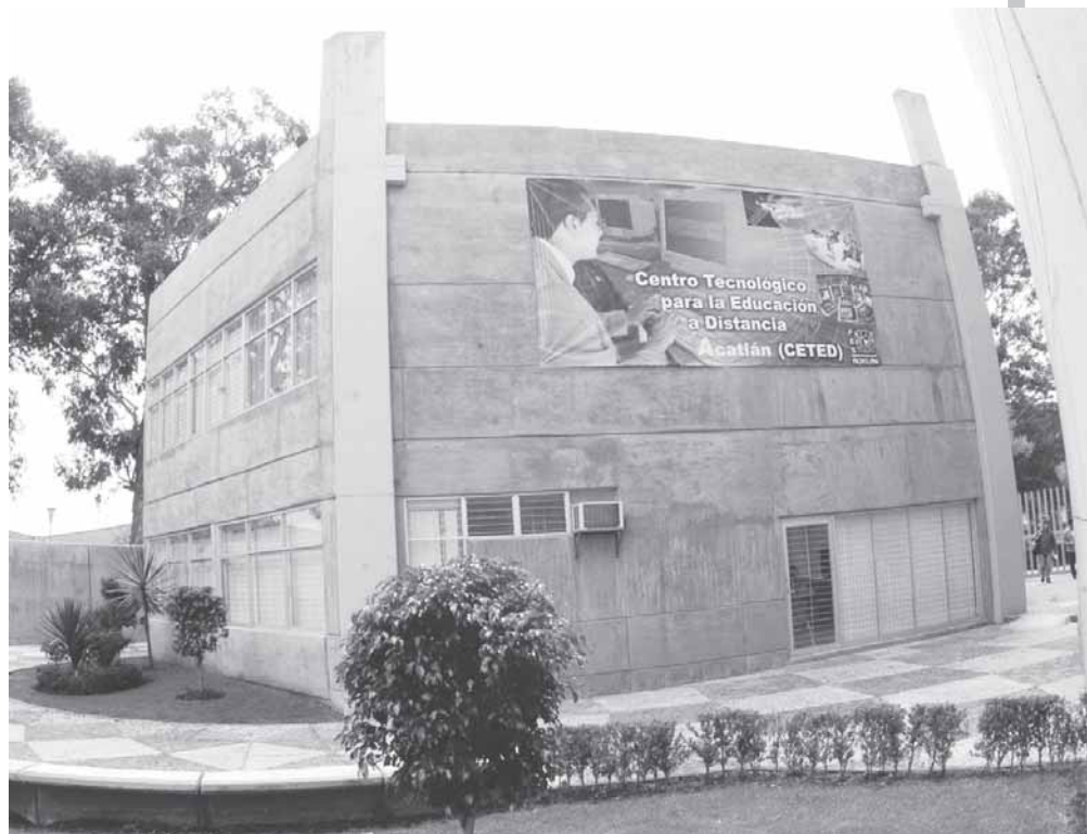
Instalaciones del Ceted. Foto: Juan Antonio López.
