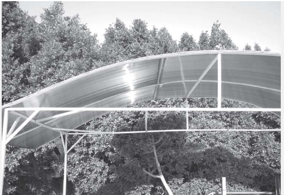
Domo en el CIE. Fotos: cortesía del Centro de Investigación en Energía.
