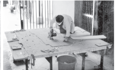
Desbastado del soporte de la tercera sección.
