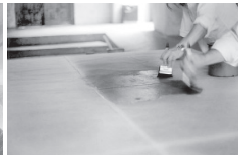
Colocación del velado de protección.
