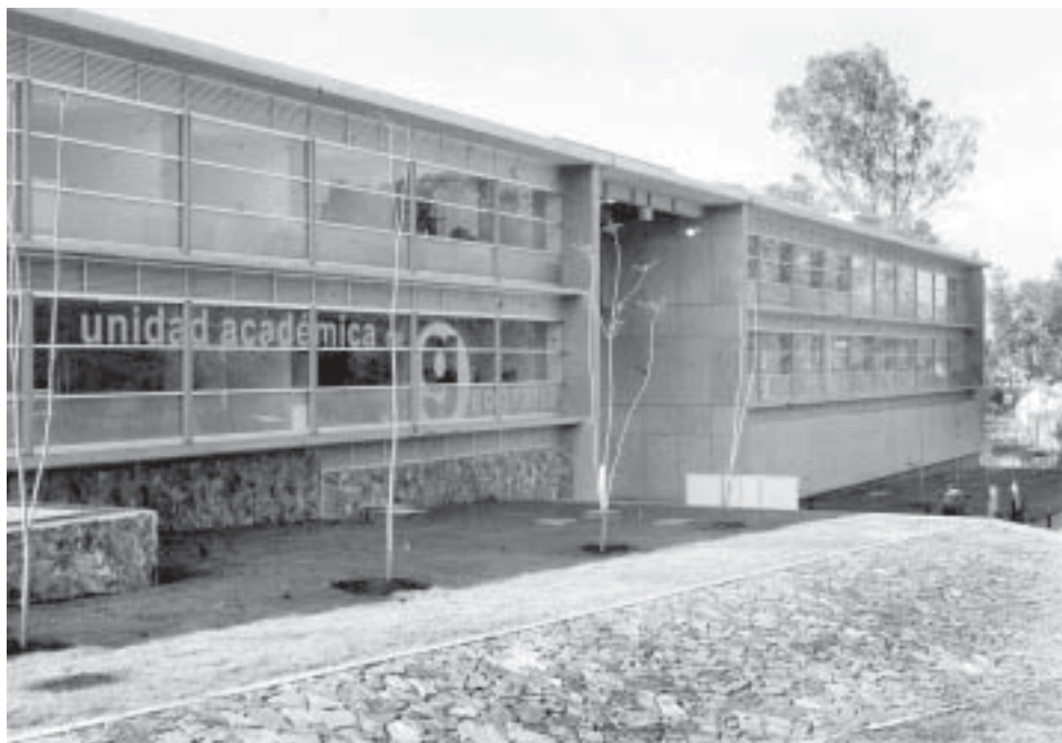
Las nuevas instalaciones. Fotos: Benjamín Chaires.
