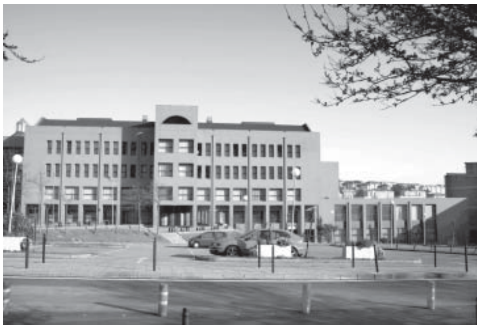
Edificio Interfacultativo, Universidad de Cantabria. Foto: Internet.
