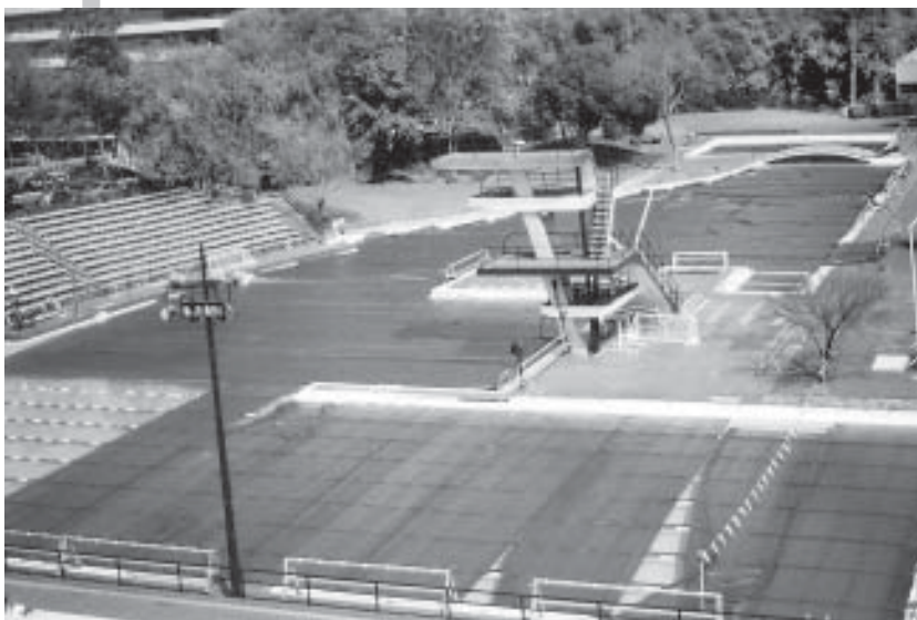
PROTECCIÓN. Desde hace días la Alberca de Ciudad Universitaria cuenta con una cubierta plástica, que permite mantener el agua templada y más limpia. Fotos: cortesía DGADR.
