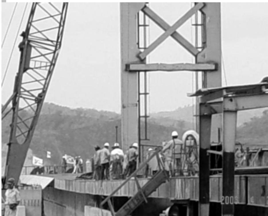
Investigadores examinan la construcción. Foto: cortesía II.
