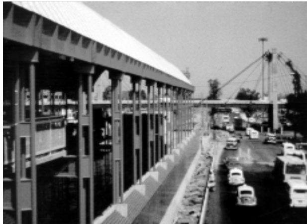
Metro de la ciudad de México; línea A. Foto: FA.
