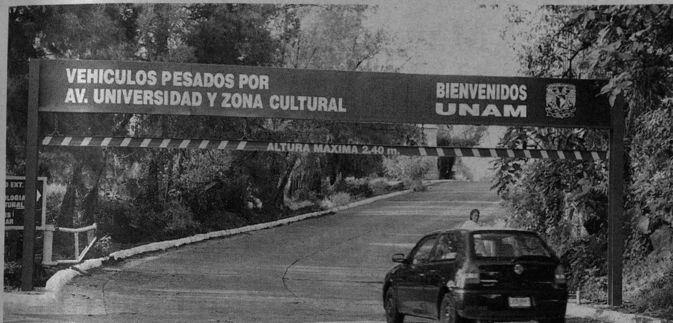
Marcos de nivel para controlar el acceso de vehículos pesados.
