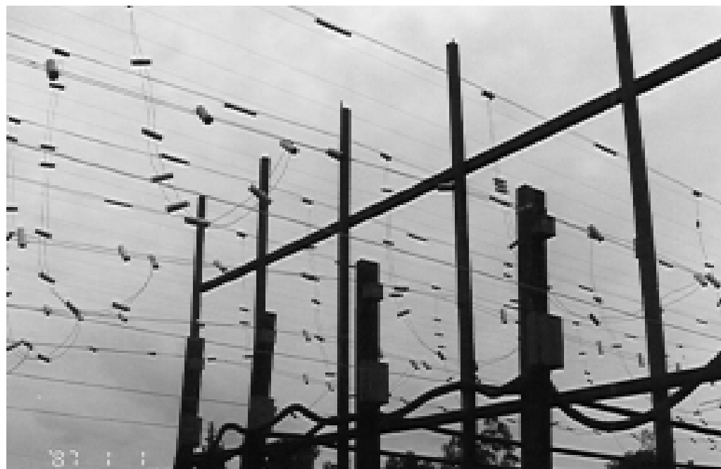
En la imagen se muestra un segmento de la antena prototipo en Teoloyucan, Estado de México, constituida por dipolos y se aprecia también parte de la electrónica de campo y energía de alimentación de la antena.
