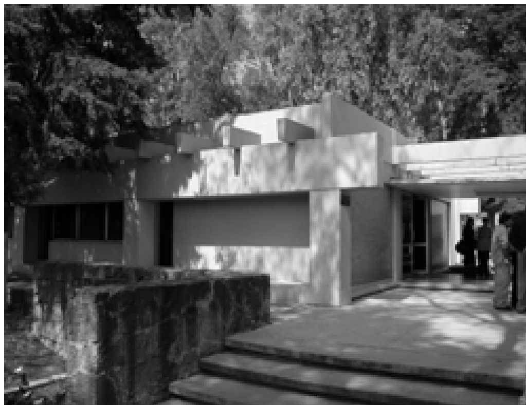
El edificio que entregaron a Iztacala.
